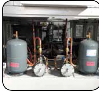
Birbirinden Bağımsız Gaz Devresi Double Cooling Circuits
