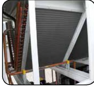
V Tipi Kondenser Dizaynı V Type Designed Condensers
